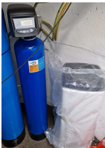
1 pav. Pilotinis filtras su „ecomix“ užpildu.
