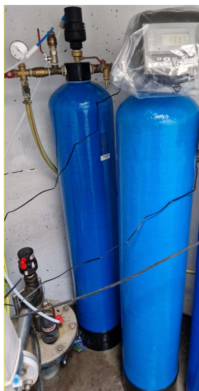
2 pav. Pilotinis filtras su oksidatoriumi ir kvarcinio smėlio užpildu.
